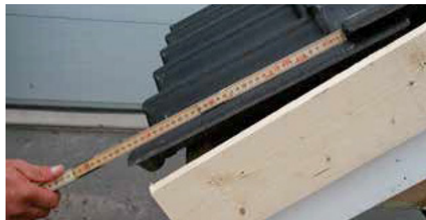
Рис. 7 Измерьте видимую нижнюю (не перекрытую) часть нижнего ряда черепицы.
