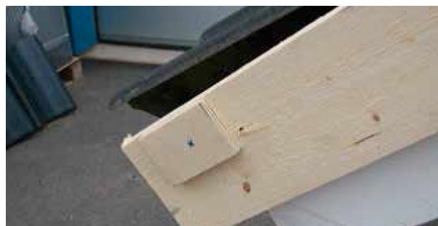
Рис. 9 Прикрепите дополнительный деревянный брусок к ветровой доске.
